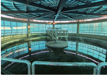
鐵嶺肉品廠污水 處理設施升級改造
