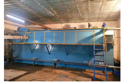
遼陽食品廠氣浮機汰舊換新
