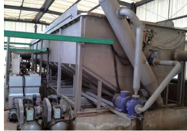
蚌埠食品廠汽浮機升級改造
